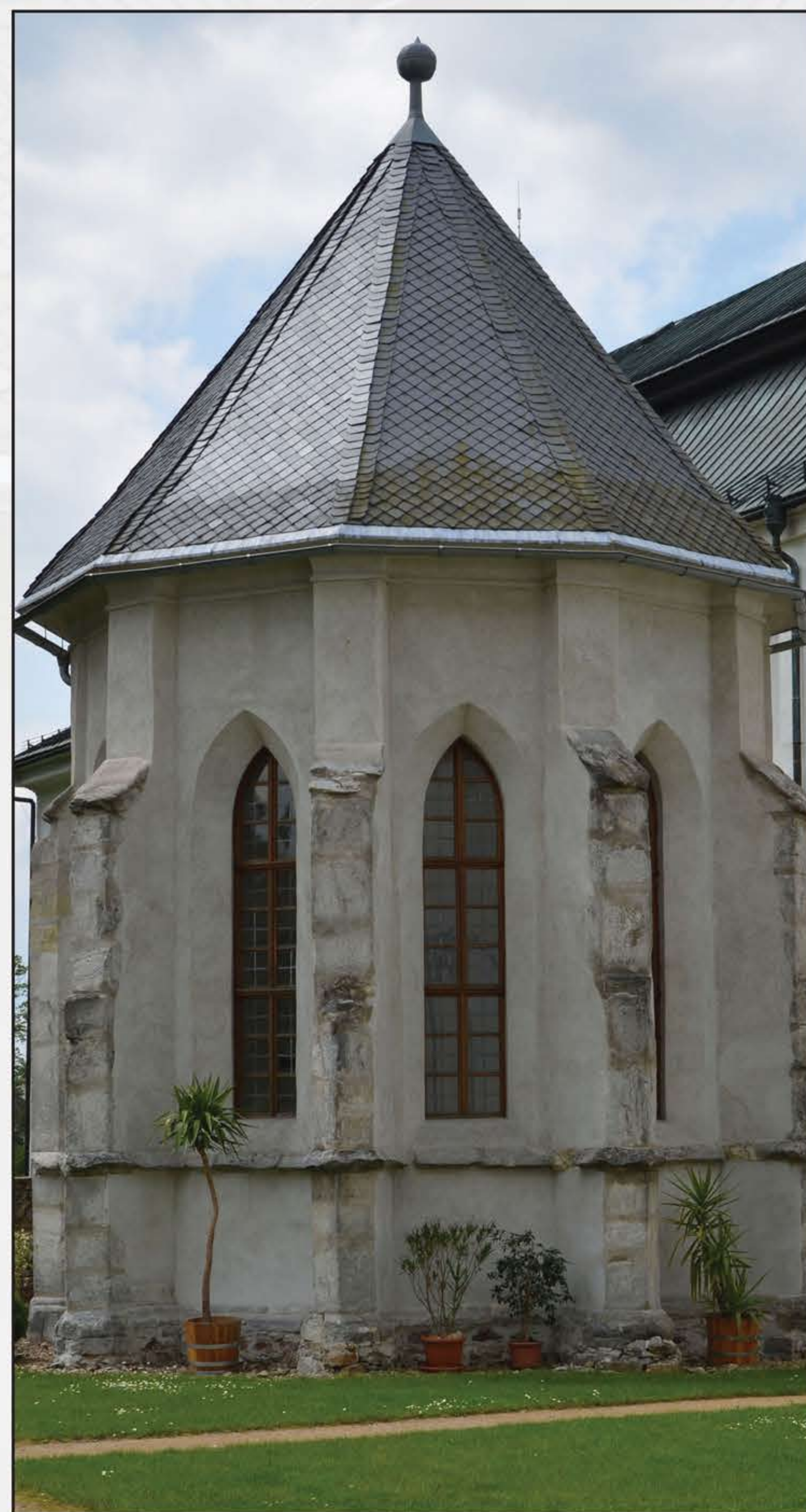
Gotická studniční kaple žďárského kláštera, 1250–1275
