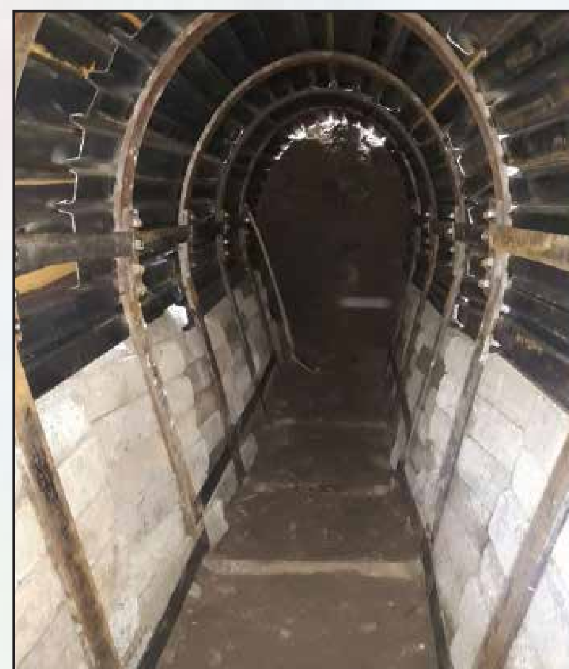
Část zpřístupněné chodby do podzemí vulkánu, zajištěné profilem typu „pražské rámy“
